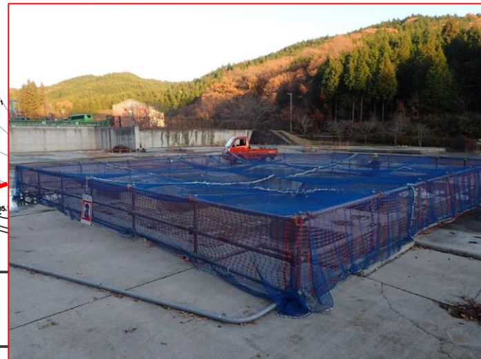
換気立坑口 安全ネット設置状況
