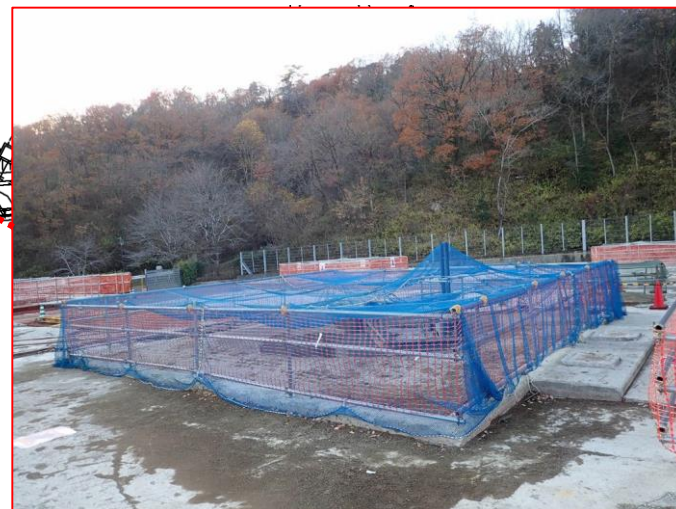
換気立坑口 安全ネット設置状況
